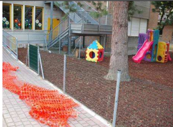
Lavori con corteccia
