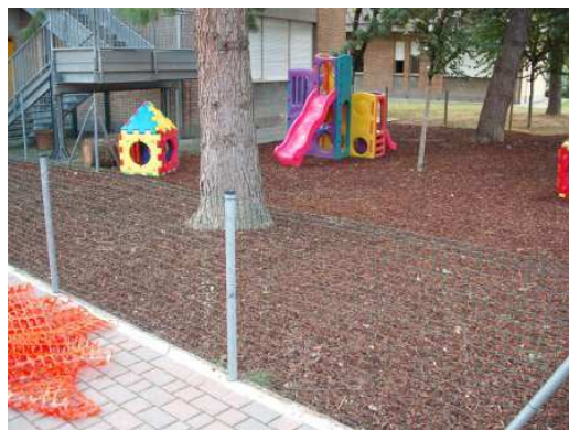
Lavori con corteccia
