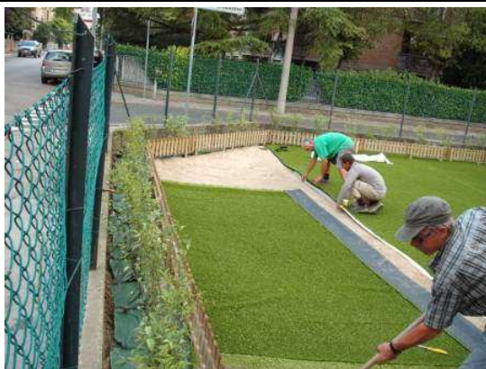
Posa prato, siepe e staccionata
