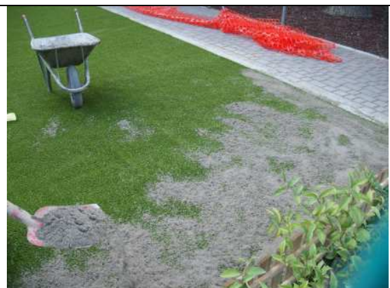
Tamponatura con sabbia
